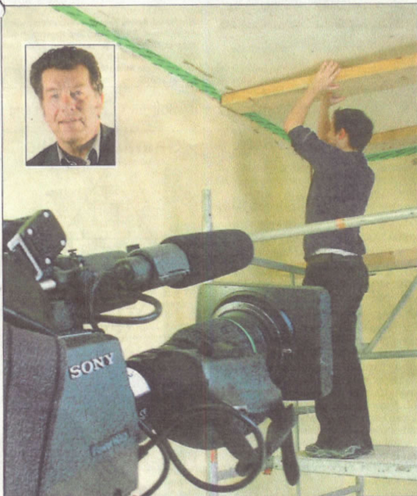
Unter den Augen der Kamera wird die Holzdecke durch eine untergespannte Bohle verstärkt. Professor Gerhard Berg (kleines Foto) hat das System entwickelt.
