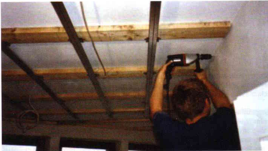
Montage der Federschielen.
