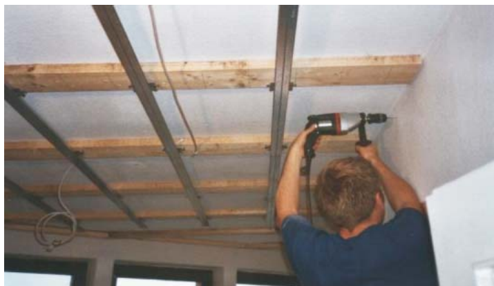
Montage der Federschielen
