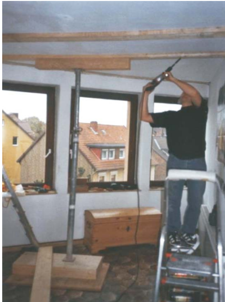
Schubfeste Verschraubung der vorgebohrten Bohlen
