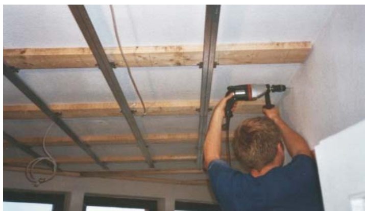
Montage der Federschielen
