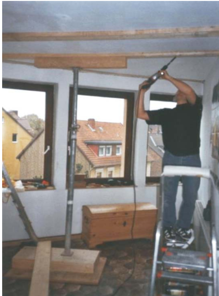
Schubfeste Verschraubung der vorgebohrten Bohlen
