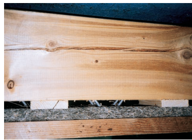
Schubfeste Verschraubung des unterspannten Balkens
