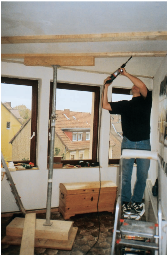
Schubfeste Verschraubung des unterspannten Balkens
