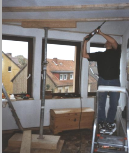
Schubfeste Verschraubung der vorgebohrten Bohlen
