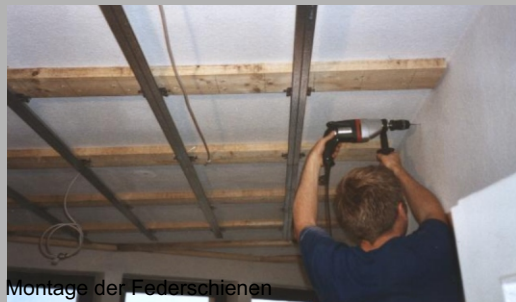
Montage der Federschiene
