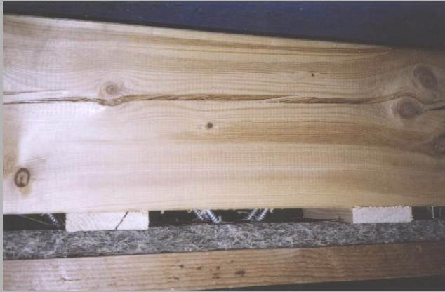
Stabfeste Verschraubung des unterspannten Balkens
